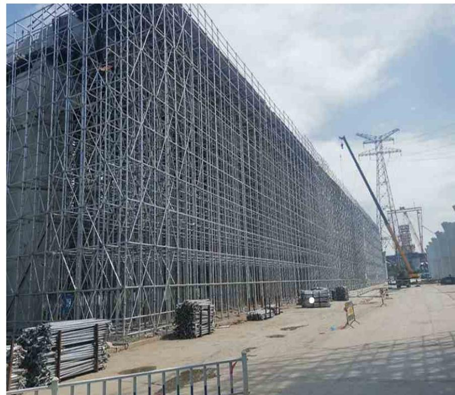
承插型盘扣式脚手架示例图
