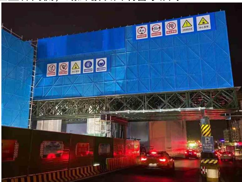
钢制爬架防护网代替安全网的外脚手架示例图
