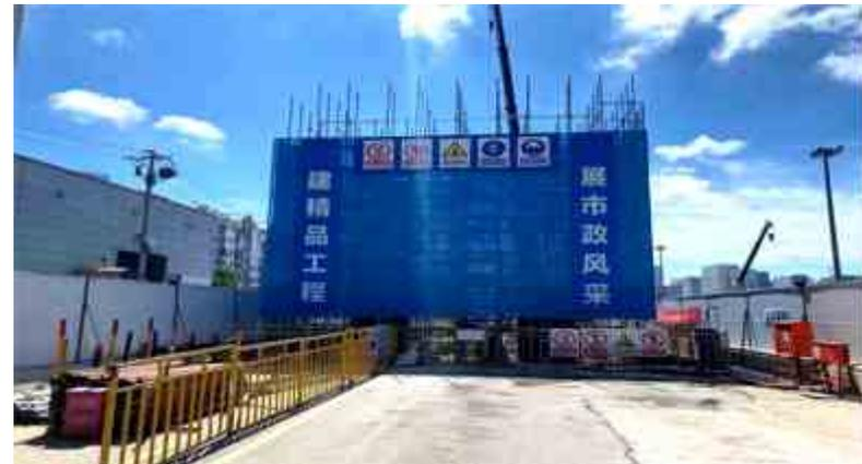
钢制爬架防护网代替安全网的外脚手架示例图
